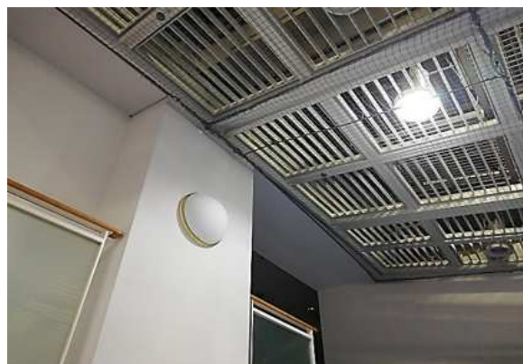
防護ネット柵取付完了状況
