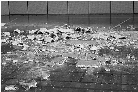
愛知県大治町の町立大治小学校体育館で発生した天井吹付材の剥離事故（2015年5月）
