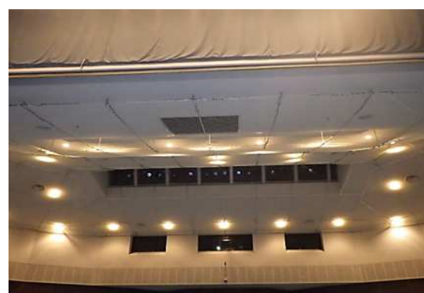
防護ネット柵取付完了状況
