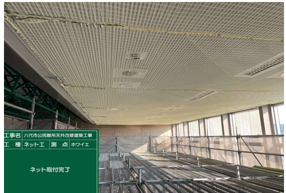
防護ネット柵取付完了状況
