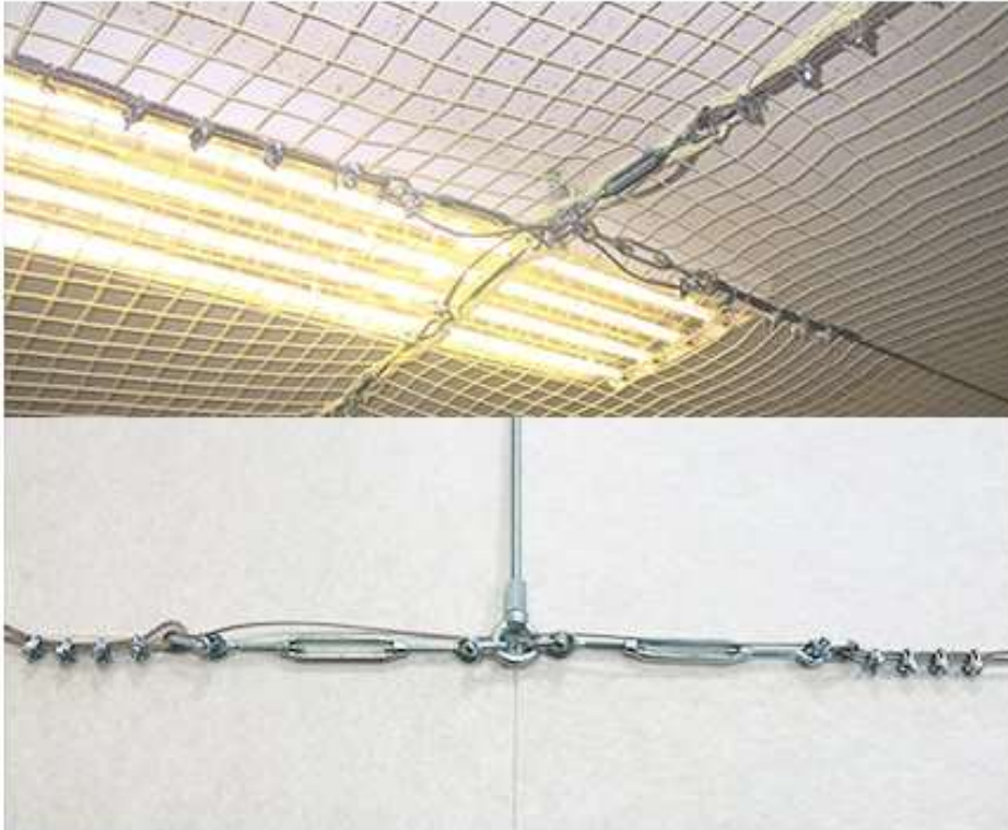
独自のワイヤー取り付け工法（Wジョイントワイヤー工法）とその設置例
