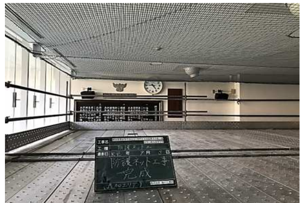
生徒ラウンジ 既存天井用防護ネット柵工事
