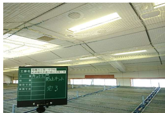
防護ネット柵取付完了状況
