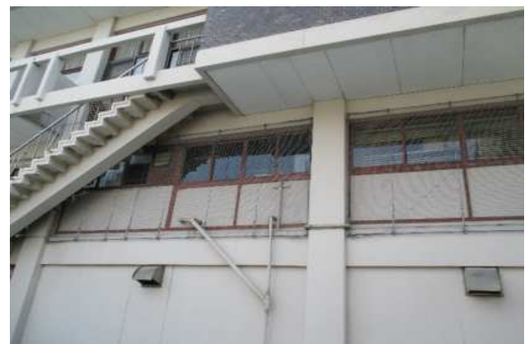
防護ネット柵取付完了状況
