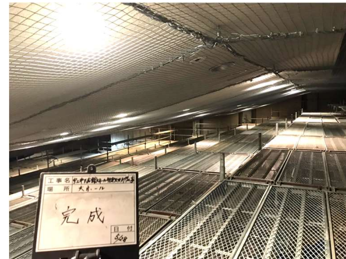
④ ワイヤーにネットを取り付ける
